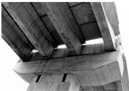
rebrasta struktura sa montažnim omnia pločama povrh
